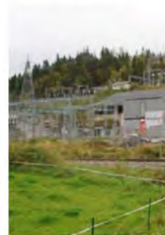
BYGGER MER NETT: Det pågår et stort arbeid forteller Bengt Eidem i Tensio. FOTO: RITA KLEVEN
