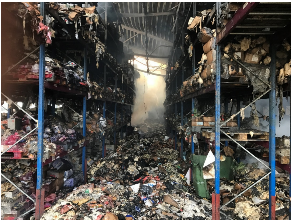
Figur 4-4: Bilde fra inne i fryselageret, kl. 19:09 tirsdag 11. april (fase 2 av brannen). Figuren er fra [63], gjengitt med tillatelse.
