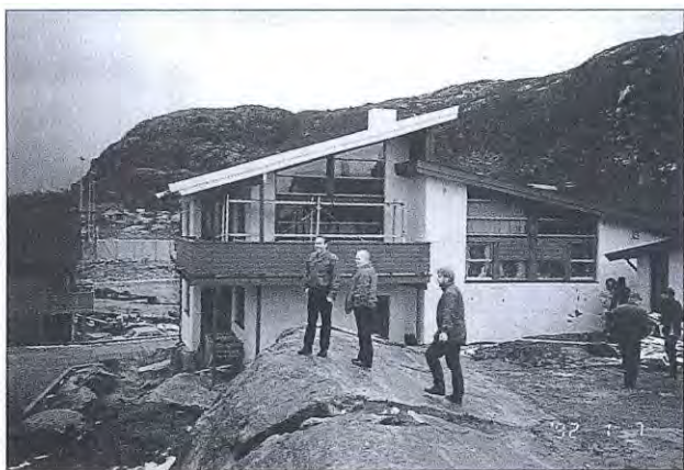
Hele takflaten til venstre blåst av. Nytt, lyst materiale viser tak som er bygd opp på nytt.
