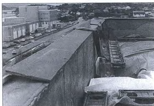
Folietekt tak over tre etasjes kontorbygning Skaden startet antakelig med at det røk i takkanten (første bilde). Skadeomfanget går frem av de øvrige bildene.
