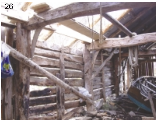
Grindbygd naust i Havåg, Ulstein (under vøling). Huset skal vere det eldste på garden.
