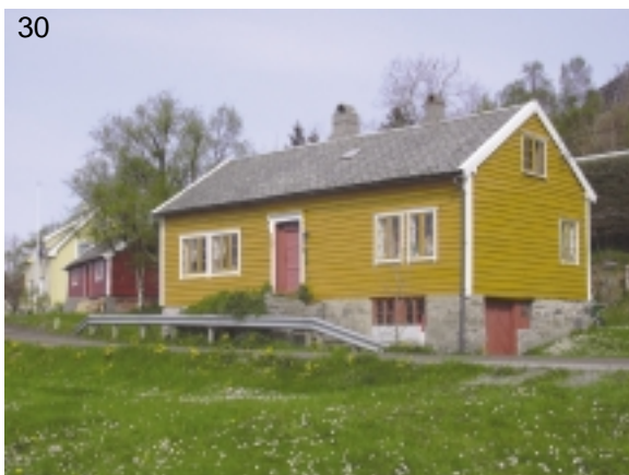
Frøystad i Herøy. Her er vedlikehaldet betre. Ved diverse reparasjonar er det blitt brukt detaljar i sveitserstil. Slike låge hus frå før 1900 vert ofte kalla lemstover.
