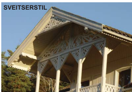
Gode eksempler på riktig utførelse og dimensjonering av gesims og vindski i sveitsersstil
