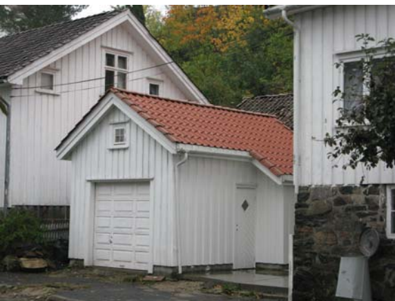
Garasje innpasset mellom to eksisterende bolighus. Godt utformet, men leddport skulle ikke vært benyttet.
