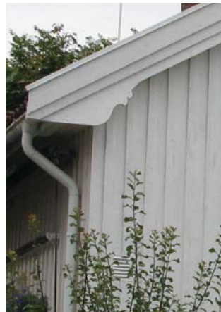
Uheldig vindskiuforming på restaurert hus i empirestil. Takrenner og nedløpsrør bør være i sink og med skarpvinklede, loddete benn (se s.15).
