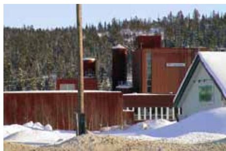
Det platekledde produksjonsbygget til Tine meierier har en god sammenstilling av volumer.
