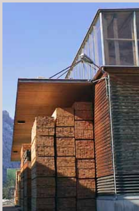
Et trelastlager med spennende bruk av tre i konstruksjoner og uttrykk reklamerer for sine produkter uten skrift og fete typer.
