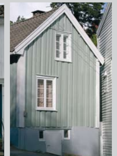
Tømmersmannskledning Amaldus Nielsens gate 13
