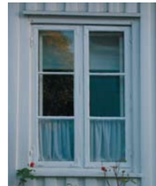
To-rams med 3 ruter i hver ramme. Ytre Sandgate 20 og Ytre Sandgate 8
