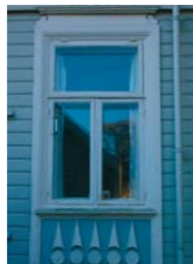
T-post, en ramme i øverste felt, to rammer nederst. Ytre Sandgate 22b
