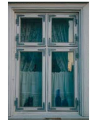
Nytt krysspostvindu med hjørnebeslag. Beslagene må males. Kastellgata 1
