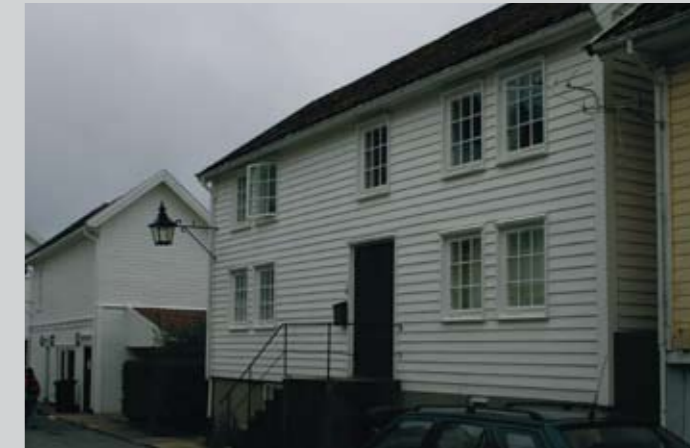
Torris Christensens gate 15. Tilbakeføring fra 1950-talls «funkis» til 1700-talls vindusformat. Avdekking av tømmervegg avslørte de opprinnelige vindusåpningene. Det er ikke alltid ønskelig med tilbakeføring av fasader. Antikvariske myndigheter mener at man bør vise den historiske utviklingen.
