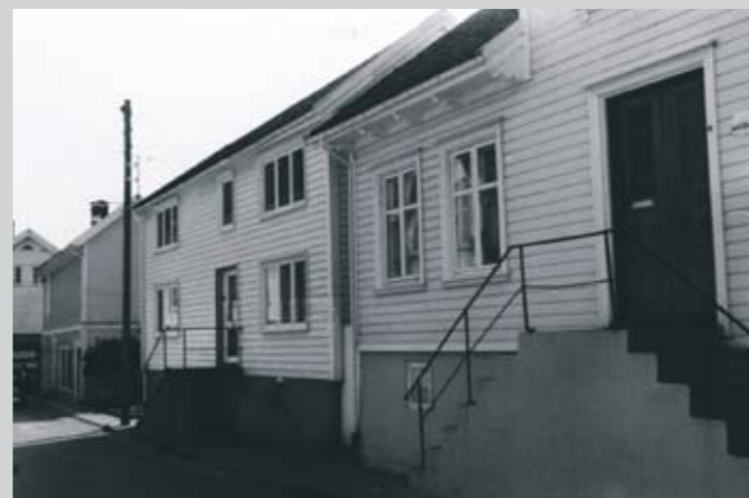
Torris Christensens gate 15. Tilbakeføring fra 1950-talls «funkis» til 1700-talls vindusformat. Avdekking av tømmervegg avslørte de opprinnelige vindusåpningene. Det er ikke alltid ønskelig med tilbakeføring av fasader. Antikvariske myndigheter mener at man bør vise den historiske utviklingen.
