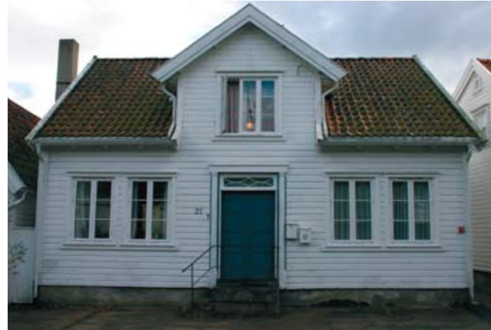
Dobbelfalset kledning. Ytre Sandgate 21
