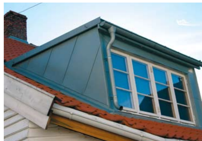
Nybeslått eldre kvist, med takrenne og nedløp i forpatinert sink. Store Elvegata 25
