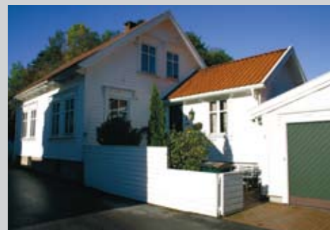
Giert Giertsens gate 13. Mindre tilbygg i forlengelse av huset, med samme hovedform.
