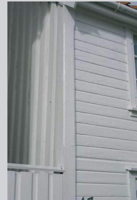
Opprinnlig kledning på gavl. Ytre Sandgate 17
