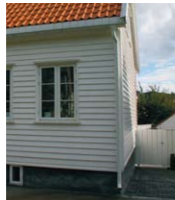
Ny, hvitlakkert stålrenne og nedløp. Kirkemurgata 1
