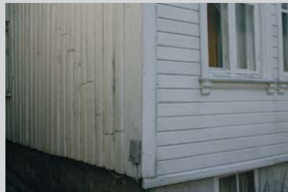
Sveitserdetaljer mot gate, opprinnlig kledning på gavl. Nordgata 4 øverst og Kastellgata 1 nederst.
