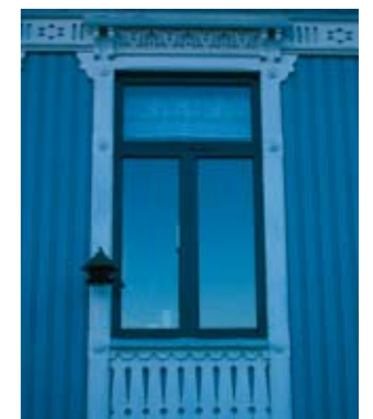
Nytt vindu innsatt med nytt og gammelt listverk.
