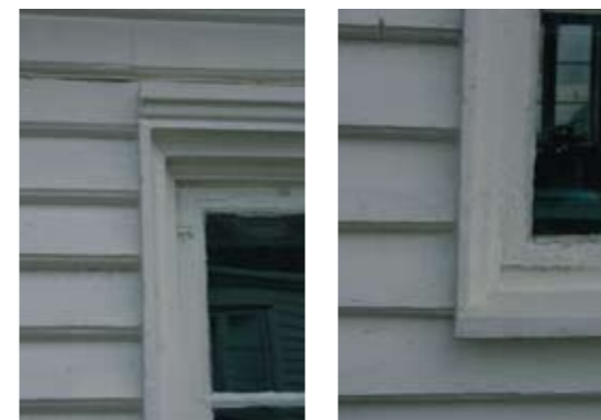
Vindusdetalj Ytre Sandgate 8. Se detalj 2
