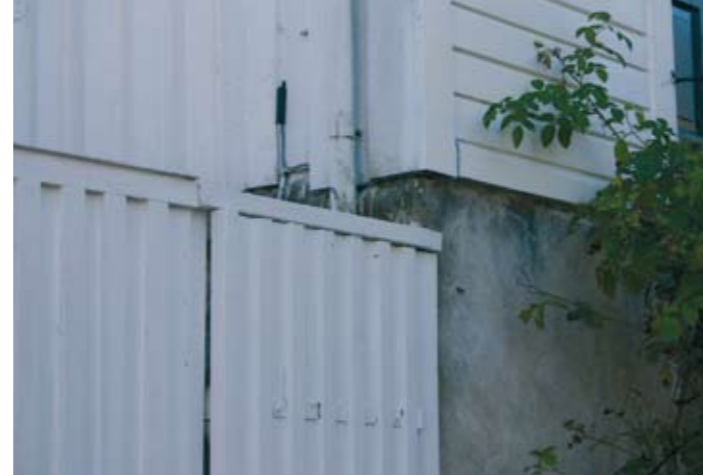
Dobbelfalset kledning mot gate, tømmermannskledning på gavl. Giert Giertsens gate 20
