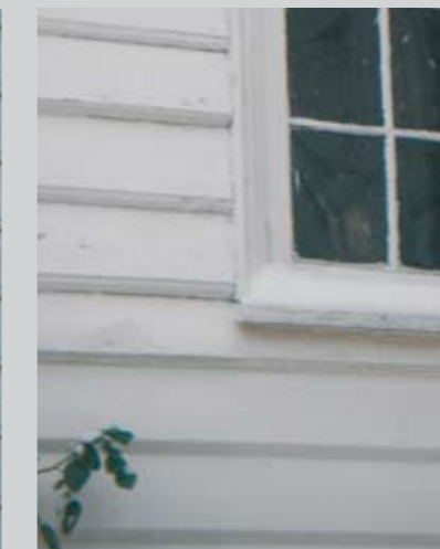
Gammel kledning øverst. Utskiftet ny kledning nederst. Store Elvegata 25
