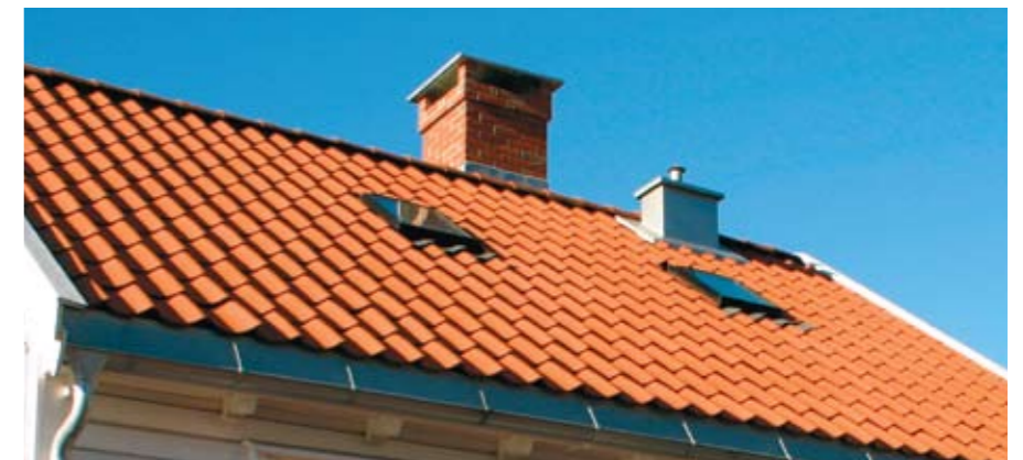
Nytt hus med oppmurt pipe i tradisjonell utførelse. Mellomgata 8
