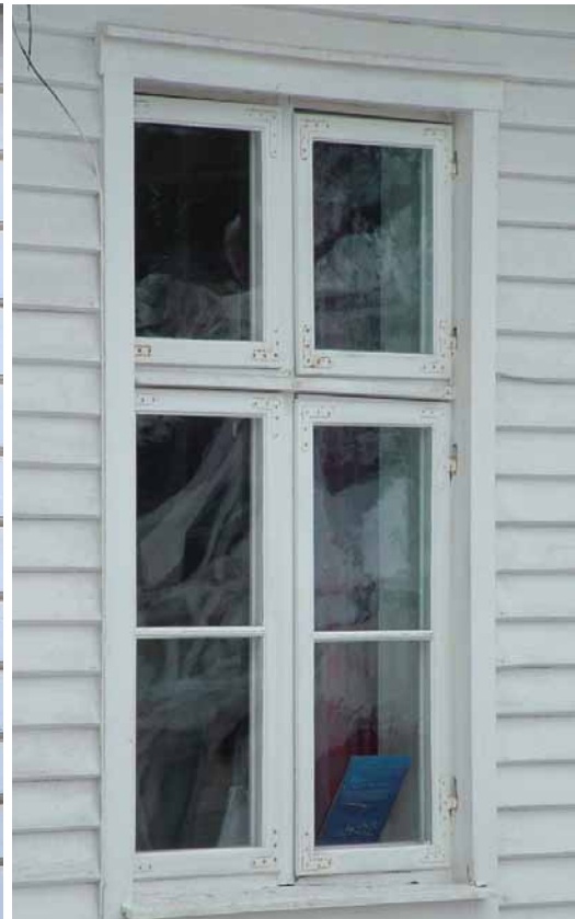
Reparert vindu - Kirkegaten 56
