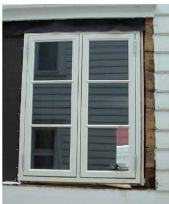
Vindu med enkelt isolerglassvindu satt i kittfals (Isospross)
