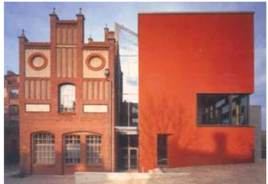
Zentrum für umweltbewusstes bauen, Jordan + Müller Architekten, Kassel, Tyskland Foto: Constantin Meyer © www.constantin.meyer.de
