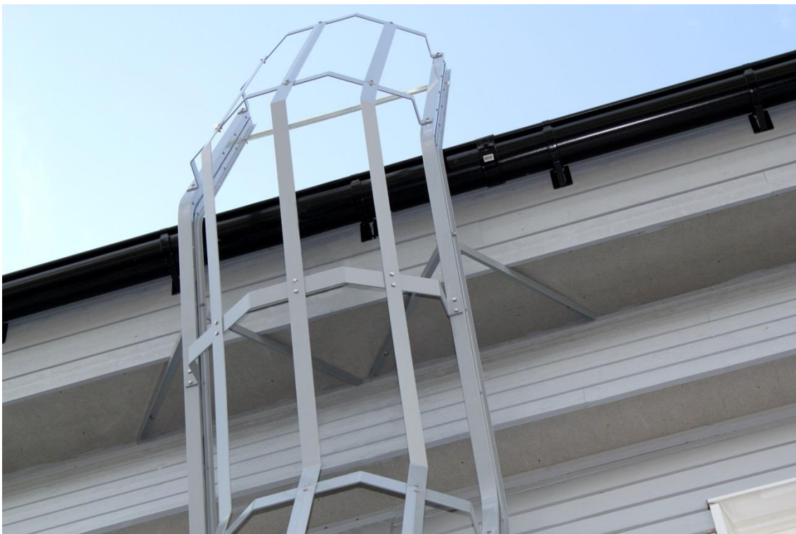
Figur 5 - eksempel på gesimsstige med ryggvern
