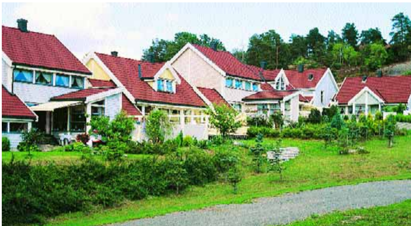
«Gi meg fem toner og det er et utrolig felt å bruke frihet i; den største frihet har du når du har rammer å virke innafor.» (Jan Garbarek, i Hareide 1997) Nabohus i Salmakerløkka i Sandefjord. Beboerne har fått tilpas-
