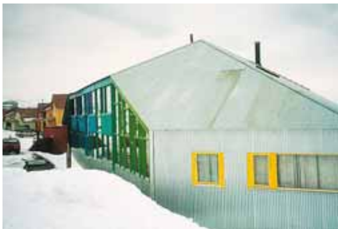
Hybelhuset i Longyearbyen er formet som en plog som leder vinden over og forbi huset. Arkitekt: Steinsvik Arkitektkontor AS. (Foto: Trude Lund)
