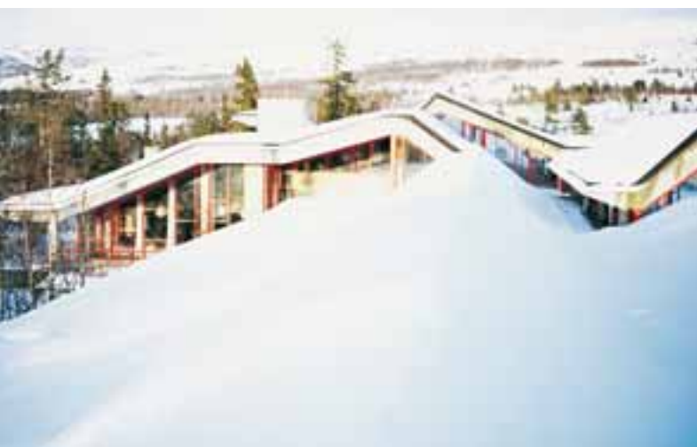
Beitostølen helsesportanlegg har gras på taket og er bygd i plassstøpt betong. Betongen har den spennende egenskapen at den lar seg forme til mer organiske former – som gjør at anlegget glir inn i landskapet. Arkitekt: Telje-Torp-Aasen Arkitektkontor AS. (Foto: arkitekten)
