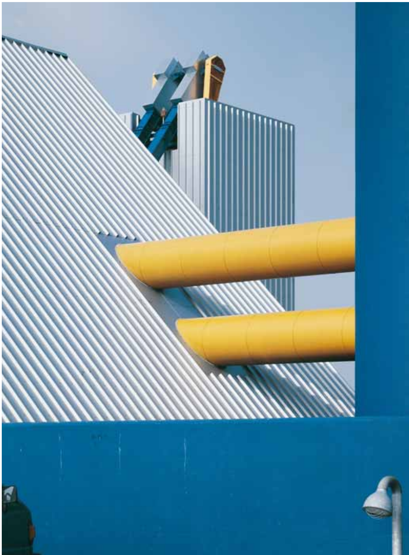
En stålplatekledning har en annen karakter enn en kledning med tre. Stålplater er et relativt nytt materiale, som kommer til sin rett i denne typen industribygg. Avfallsvarmeverk i Høje Tåstrup i Danmark (se også foto side 103). Arkitekt: Gottlieb og Paludan AS, arkitekter MAA. Foto: Jens Frederiksen
