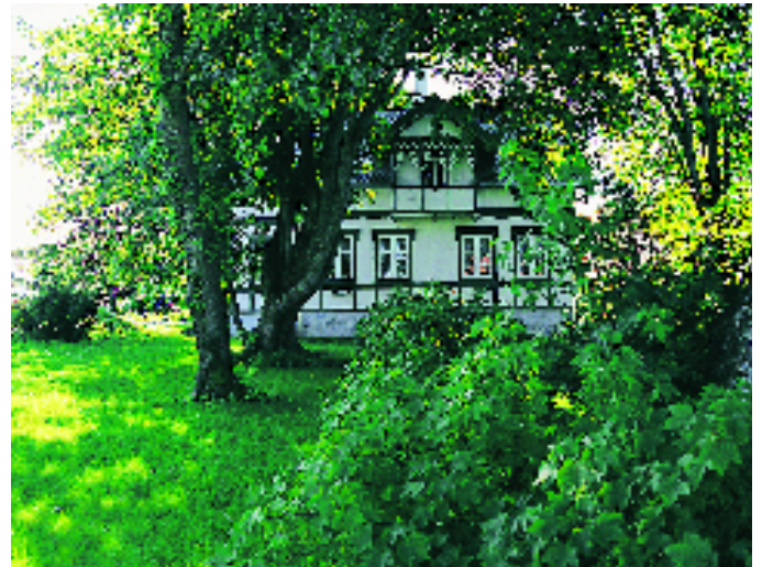
Sveitserhuset ble populært over hele landet. Her et nydelig istandsatt hus fra Bodø som fikk kommunens byggeskikkpris i 1995.
