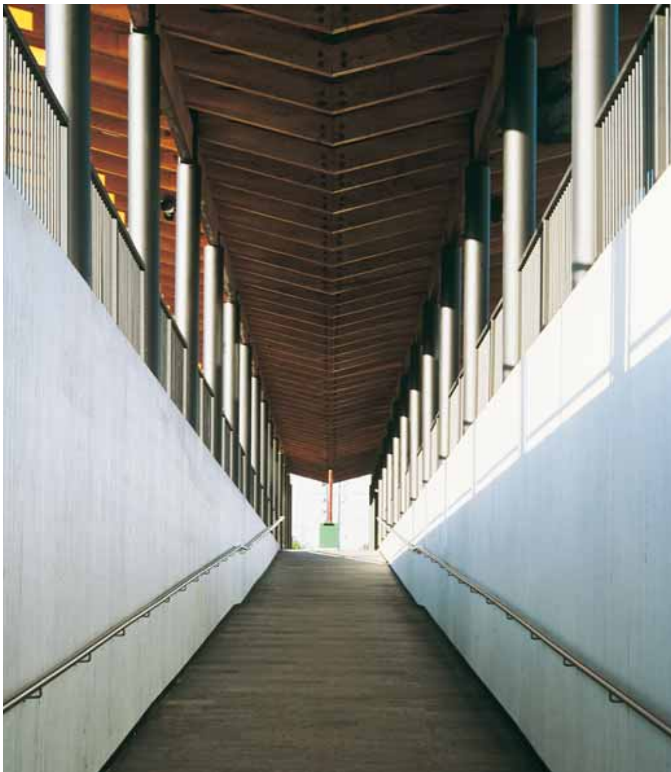
Reisen gjennom tid og sted foregår med hurtigtogsfart, med stopp bare på noen få viktige stasjoner. Her Sandvika stasjon i Bærum. Arkitekt: Arne Henriksen, sivilarkitekt MNAL. (Foto: Jiri Havran)
