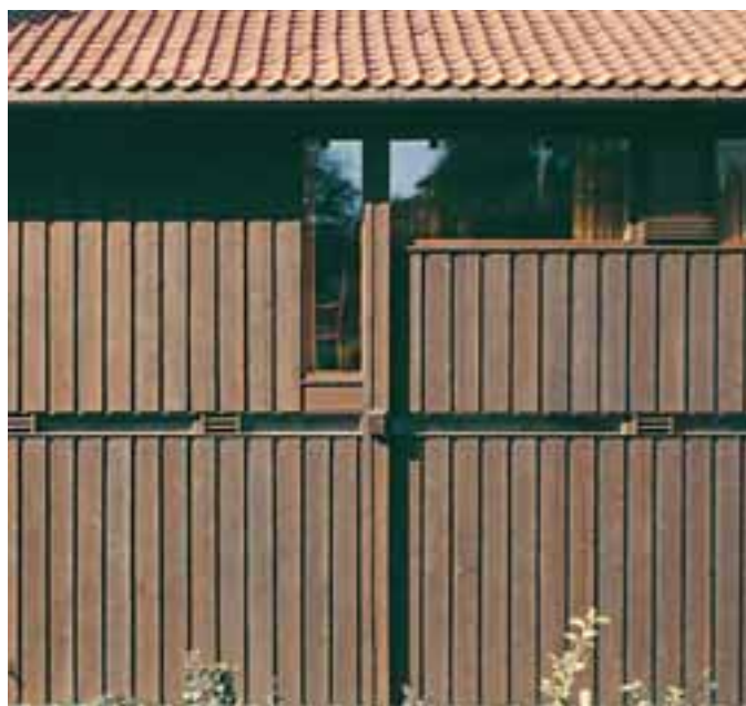
Veggen synliggjør konstruksjonen, slik at vinduer og veggflater ligger som utfyllende elementer. Enebolig på Lysaker i Oslo. Arkitekt: Lund & Slaatto Arkitekter AS. (Foto: arkitekten)
