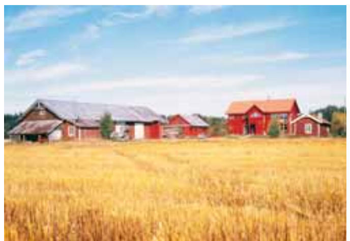
På Bjølsethgrenda ved Elverum ble det bygd nytt våningshus etter at det gamle brant. Husets hovedform, materialbruk og fargesetting knytter sammen nytt og gammelt. Vindusutformingen forteller likevel at det er et nytt hus; vi vil gjerne ha mer lys og luft i boligen vår enn det gamle smårutete vinduer gir. En villa med store verandaer og valmtak ville passe dårlig her. Arkitekt: Per Edvard Berg. (Foto: Terje Forseth)
