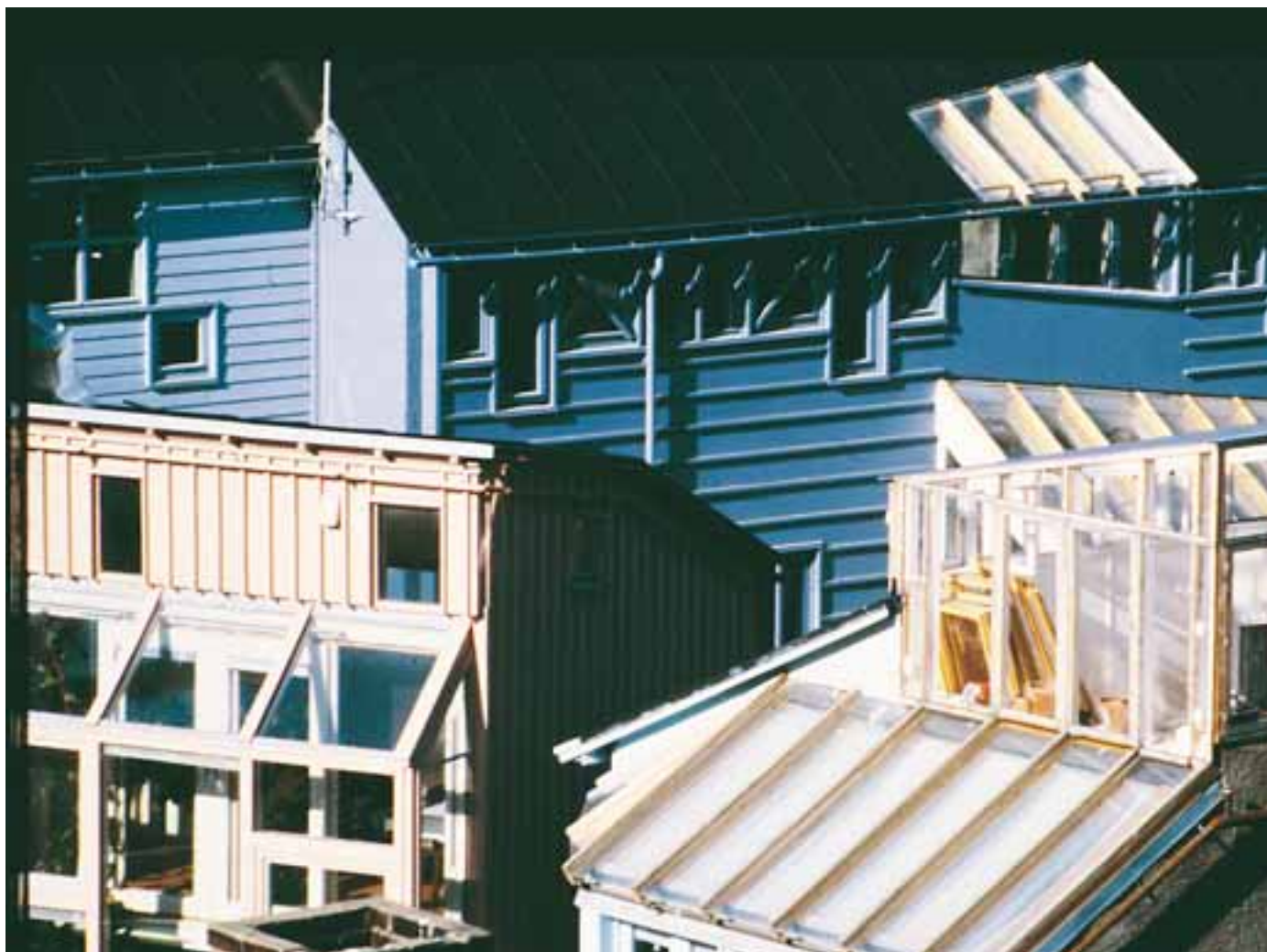
Smårutete vinduer i en ny utgave. I en trang bysituasjon kan man få ekstra lys inn i rommene ved hjelp av overlys. Nye boliger og kontorer i Grønnegata i Trømsø. Arkitekt: blå strek arkitekter AS. (Foto: arkitekten)
