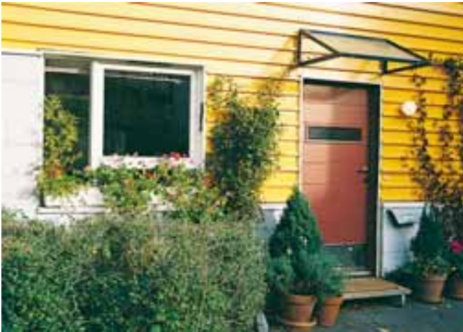
Det er mulig å ta i bruk nye materialer bare man bruker dem riktig. Fasaden er kledd med stålplater, men den nederste delen av veggen, der fare for skader er størst, er murt i Leca. Inndekningen rundt vinduer og dører er løst på en enkel måte uten bruk av «klumpete» lister og beslag. De varme fargene oppveier stålplatenes kjølige karakter. Casinetto borettslag, Oslo. Arkitekt Telje-Torp-Aasen Arkitekter AS
