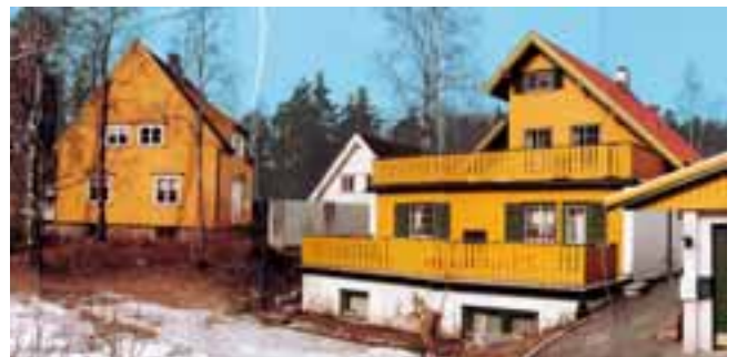
KONFLIKT - Volum og form - Den nye villaen til høyre har et oppløst bygningsvolum og skjevt røstet tak som sammen med fremskutte etasjer er i konflikt med de enkle nabohusene med saltak. En halvt nedgravd undertetasje er fremmed for strøket og vitner om dårlig terrengtilpasning. Materialer, detaljer og farger - Tilpasning ved hjelp av farge og materialbruk demper ikke konflikten.
