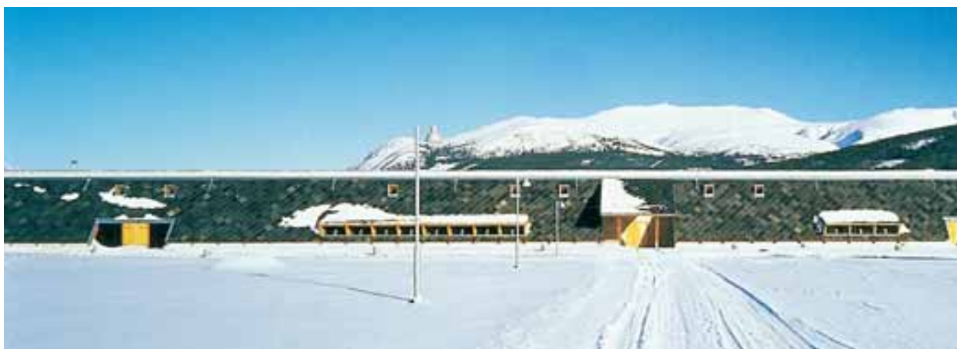
Aukrustsenteret i Alvdal ligger som en «demning» i landskapet. Bygningen er lukket mot veien og åpner seg mot landskapet (se også foto side 24). Arkitekt: Sivilarkitekt MNAL Sverre Fehn. (Foto: Terje Solvang)
