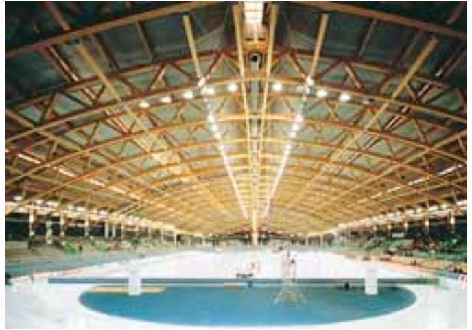
Nye byggematerialer eller ny bruk av kjente byggematerialer har hatt stor betydning for utviklingen av byggeskikken. Limtre gir muligheter for å bruke tre i større konstruksjoner, slik som i Vikingskipet i Hamar. Arkitekt: Niels Torp AS Arkitekter MNAL. (Foto: arkitekten)
