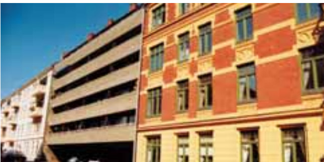
KONFLIKTFYLT KONTRAST - Volum og form - Blokken følger bebyggelsen i gaten med samme gatelinje og gesimshøyde. Skråttstilte balkongbrystninger gir en åpen, oppløst fasade med kraftig horisontal betoning. Bygget står i konflikt med de eldre bygårdenes massive, dekorerte fasader med vertikalt preg. Materialer, detaljer og farger - Materialer og farger er fremmed for strøket.
