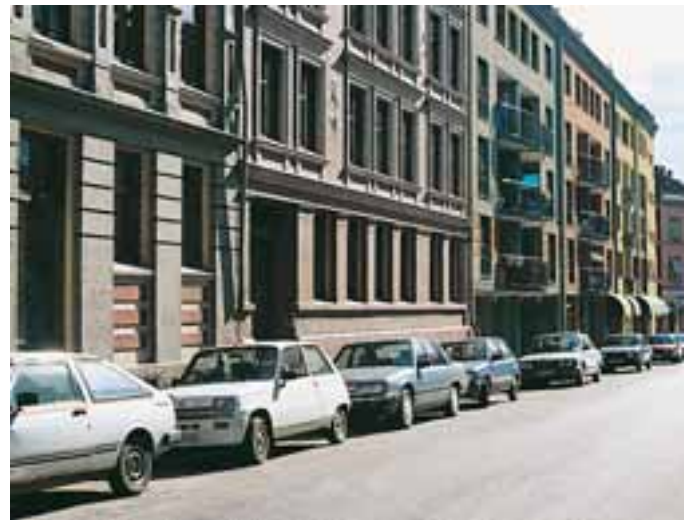
Leiegårder på Grünerløkka i Oslo. De gamle bygårdene har fått selskap av ny bebyggelse på hjørnetomta. Bygget er oppdelt i flere enheter, slik at det har samme proporsjoner (høyde og bredde) som bygården. Vertikale vindusformater og horisontale felt gjentar rytmen i de gamle husene (se også foto side 144/145 i Byggeskikkssirkelen).
