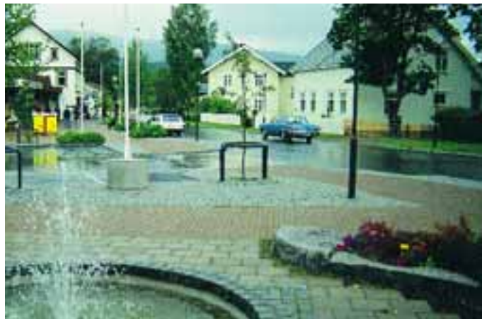
Nesbyen har ryddet opp i uklare vei- og trafikkforhold. Fortau og torg har fått nytt golvbelegg som skiller veibanen fra områder forbeholdt fotgjengere.
