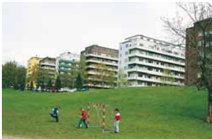
Blokkene på Marienlyst (1934–36) i Oslo utgjør det første større boligområde med frittliggende lamellbebyggelse i betong. (Foto: Andreas Gehe)
