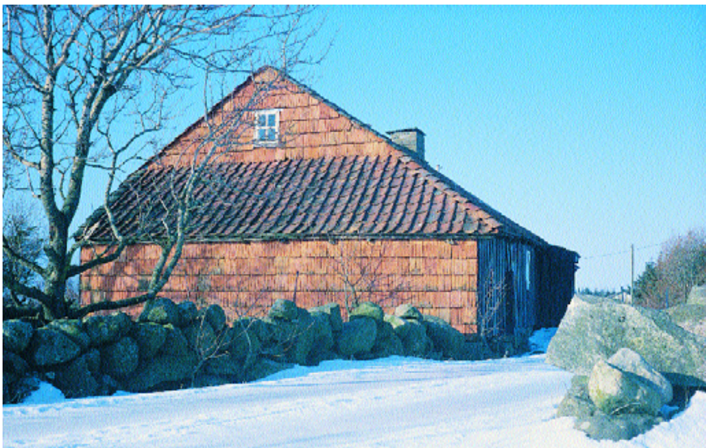
Jærhuset er tilpasset det forblåste jærlandskapet. Huset har en skut og et tilbygg på baksiden, som her er «pansret» med tegl. Skuten leder vinden opp over huset og gav sammen med tilbygget le for stuen og kjærkommen lagerplass. (Foto: Harald Høyem)
