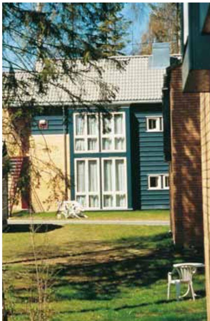
Kledning med tre og tegl skaper liv og kontraster i fasaden og gir sammen med vinduspartiet en fin nytolkning av det typiske småhuset. Studentboliger i Gjøvik. Arkitekt: JAF arkitektkontor AS v/sivilarkitekt MNAL Jan Arne Frydenlund. (Foto: arkitekten)
