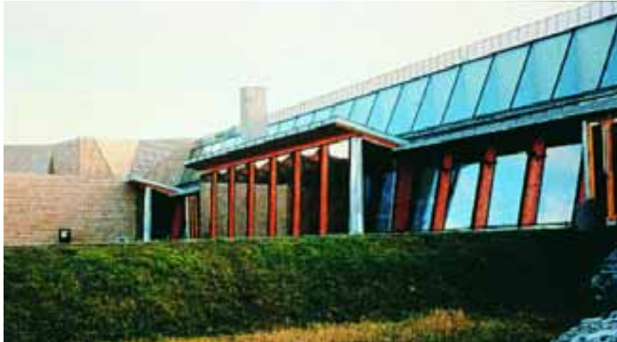
«Ein ny draum om huset ...» Aukrustsenteret i Alvdal. Arkitekt: Sverre Fehn, sivilarkitekt MNAL. (Foto: Guy Fehn)
