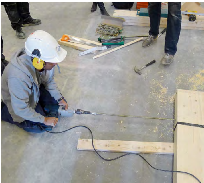
Voksenelever fra Sinsen bygger limtreramme i full skala under veiledning av lærere av Sogn videregående skole 28.mars 2012 Over: Delene i limtrerammen holdes sammen med stropper . Klosser og kiler stabiliserer rammen i vannrett posisjon før sammenføyning Til venstre: 800 mm lange skruer bores inn i rammehjørnene og gir skjulte forbindelser med stor styrke. Lærer Kjetil Hardal kontrollerer at alle hjørner ligger i samme plan.
