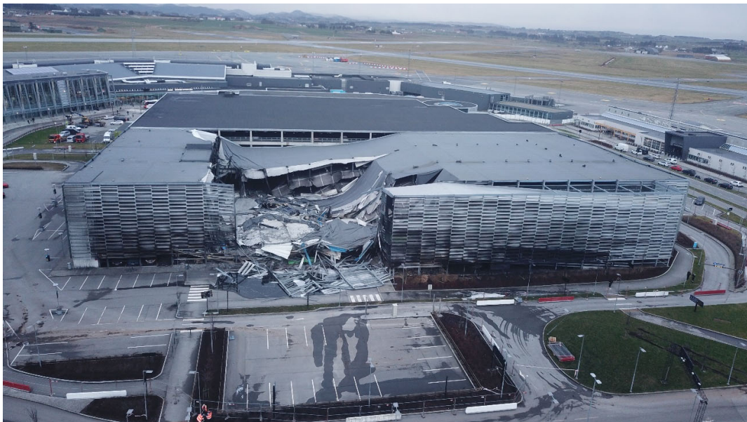
Figur 1-1 Parkeringshuset ved Stavanger lufthavn Sola etter brannen 7. januar 2020. Foto: Nordic Unmanned.
