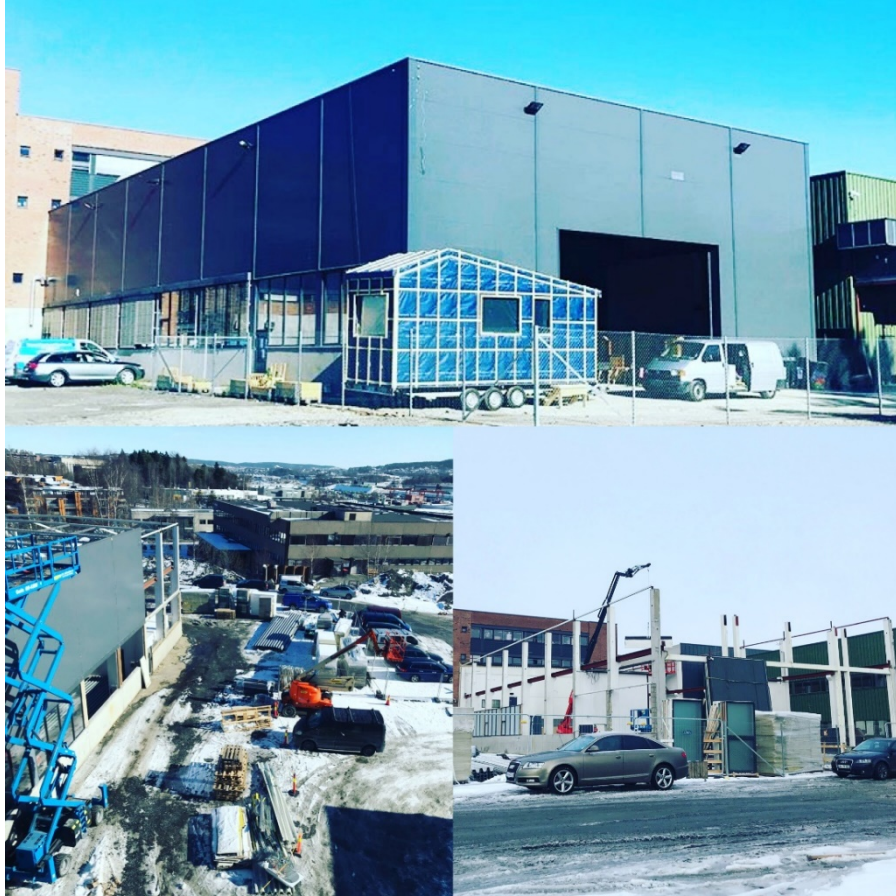
Foto: Resirqel 2018, Skånsom demontering fabrikkhall.
