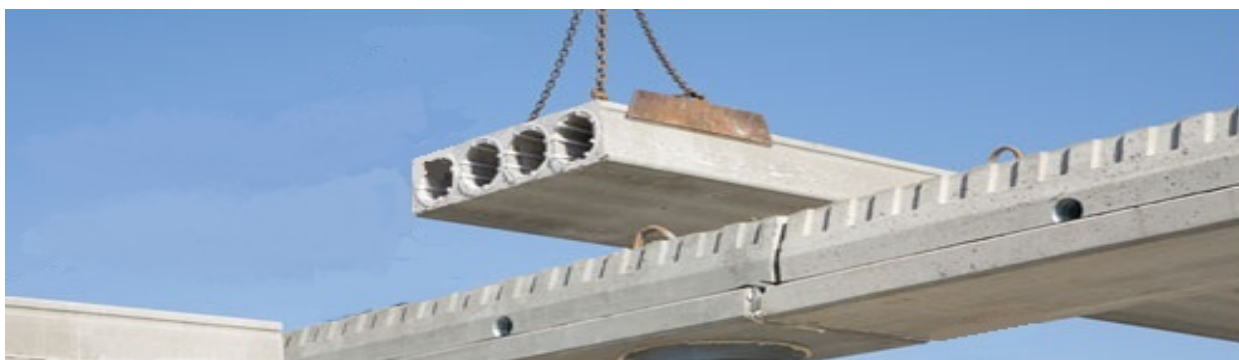
Hulldekke under heising, for montering. Illustrasjonsfoto.
