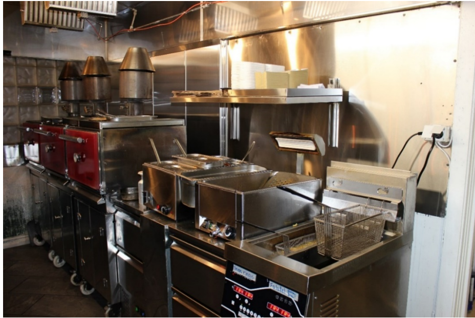
Figur 3-8 Plassering av tre kullgriller ved siden av hverandre til venstre i bilde. Rett til høyre av disse er øvrig kjøkkenutstyr plassert, deriblant frityrkoker. Ventilasjonsavtrekket for grillene er separert fra avtrekk til resterende kjøkkenutstyr.
