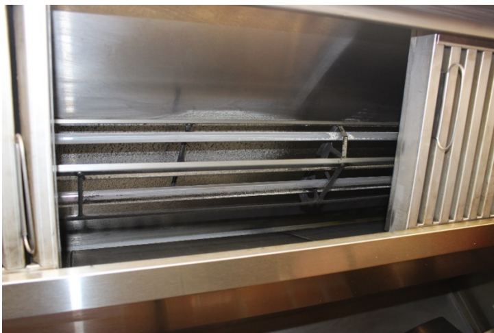
Figur 3-13 Venstre: Avtrekksystemets plassering over kullgrill. Høyre: Ytre plate er fjernet for å vise innvendig tilstand med sot.
