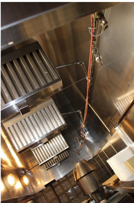
Figur 3-14 Venstre: Hver grill har en gnistfanger og en kjølehet. Høyre: Avtrekksystem for tre kullgriller ved siden av hverandre.
