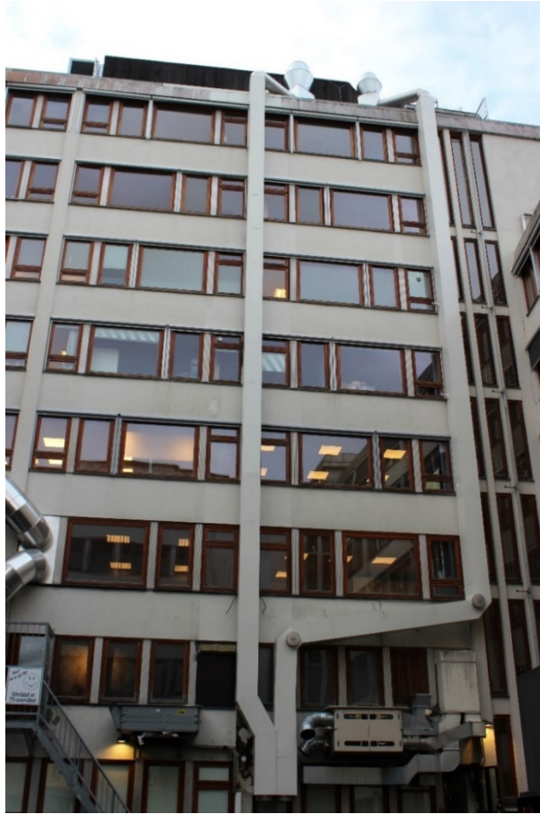
Figur 3-17 Separat kjøkkenavtrekkanal fra kullgrill går ut gjennom vegg i første etasje, fortsetter langs utsiden av fasaden og opp over tak.
