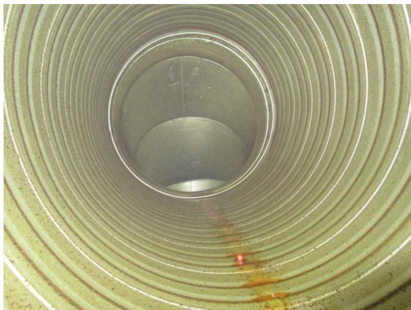
Figur 3-4 Avtrekkskanal uten innslag av sot og røyk fra grill med fast brensel, etter ca. 6 måneders bruk. UV-lys er ikke installert. Foto av Optice AS, gjengitt med tillatelse.
