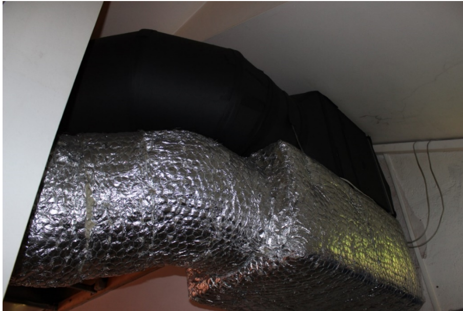
Figur 3-15 Del av ventilasjonskanal mellom storkjøkkenet og utvendig del.
