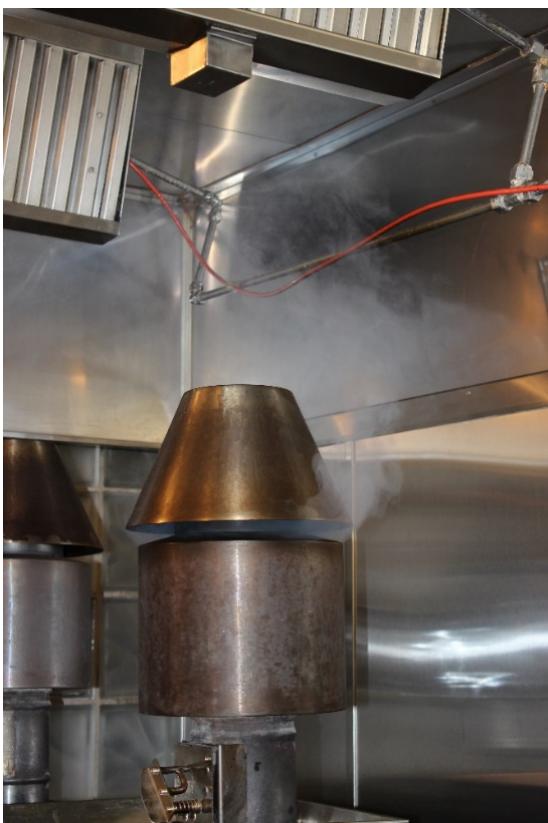
Figur 3-14 Venstre: Hver grill har en gnistfanger og en kjølehet. Høyre: Avtrekksystem for tre kullgriller ved siden av hverandre.
