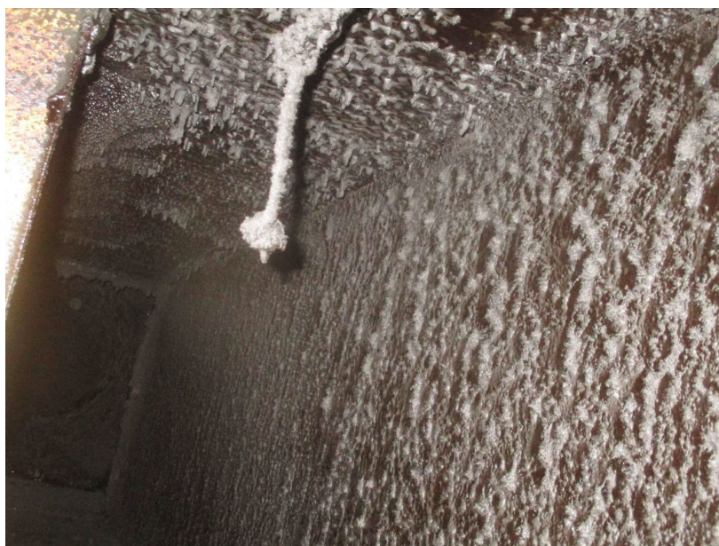
Figur 3-2 Nærbilde av kjøkkenavtrekk som betjener en lukket kullgrill, en friturekoker og en stekeplate, et år etter rengjøring. Foto av Optice AS, gjengitt med tillatelse.
