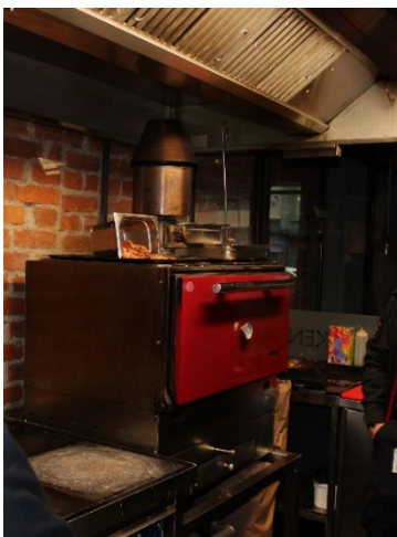
Figur 3-13 Venstre: Avtrekksystemets plassering over kullgrill. Høyre: Ytre plate er fjernet for å vise innvendig tilstand med sot.
