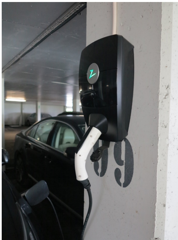
Figur 3-7 Alle ladebokser i garasjen kommer fra den samme leverandøren, og er en del av det dynamiske ladesystemet.
