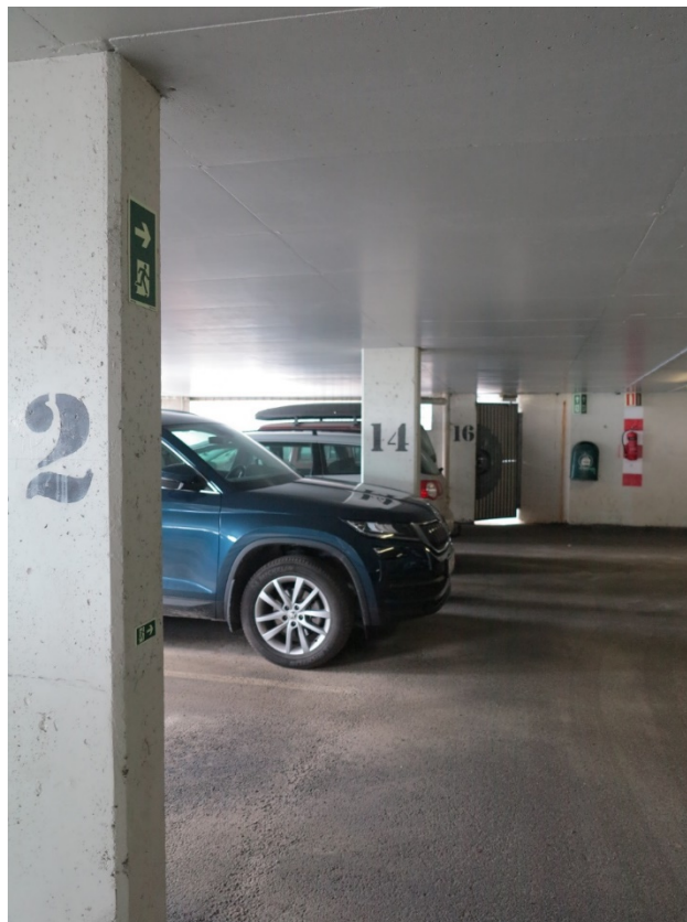
Figur 3-10 Rømningsveier er merket på flere steder i garasjen.
