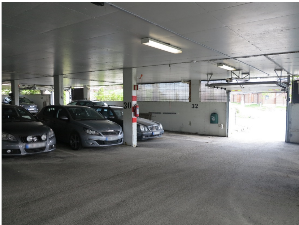
Figur 3-2 Første etasje i fellesgarasjen med to porter for inn- og ut-kjøring.
