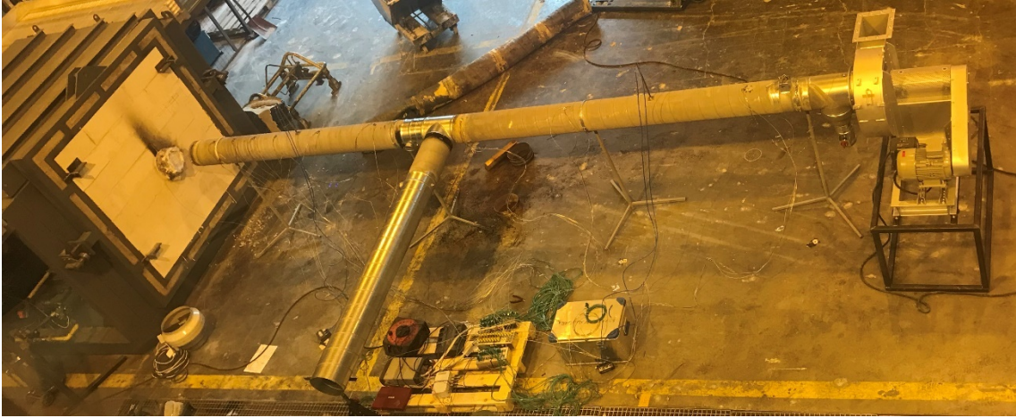
Figur 3-12 Et oversiktsbilde av oppsettet for en uisolert kanal med diameter 250 mm med innblanding av romtemperert luft. Kanalen er støttet opp med støttebein fra undersiden.
