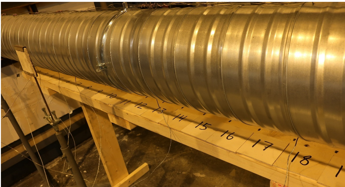
Figur 3-6 Kryssfinerplater ble plassert i en avstand på henholdsvis 50 mm, 100 mm og 150 mm fra kanalen for å undersøke om strålingen fra den varme kanalen var tilstrekkelig til å antenne treverket. På bildet er platene plassert 100 mm fra undersiden av kanalen før test.
