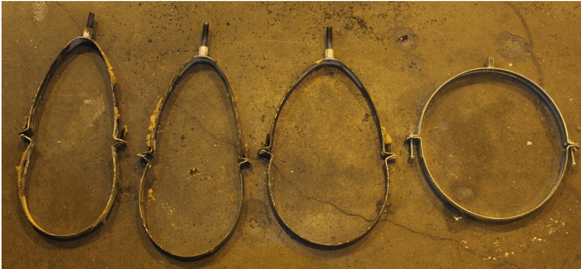
Figur 4-18 Klammerne som kanalen var festet i var tydelig deformert. Deformasjonen er størst på de to klammerne til venstre som har befunnet seg nærmest ovnen. Et referanseklammer, til høyre, er lagt ved for å synliggjøre deformasjonen. Bildet er fra test R4.
