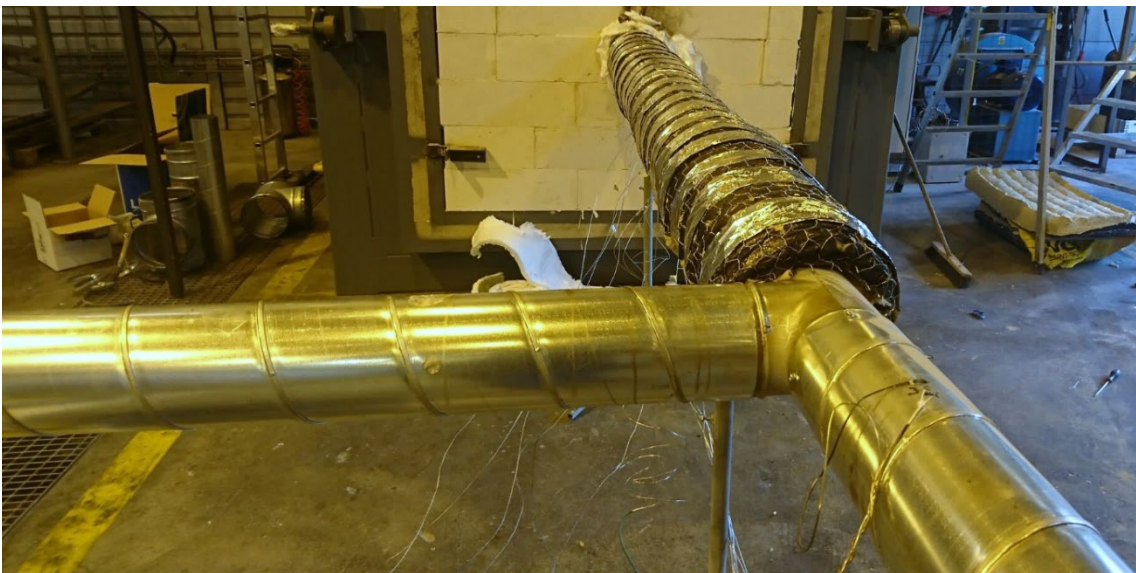
Figur 3-13 Kanal med diameter 125 mm kledd med isolasjon i 2,8 m av rørets lengde, og med innblanding av romtemperert luft der isolasjonen tar slutt. Kanalen er støttet opp med støttebein fra undersiden.
