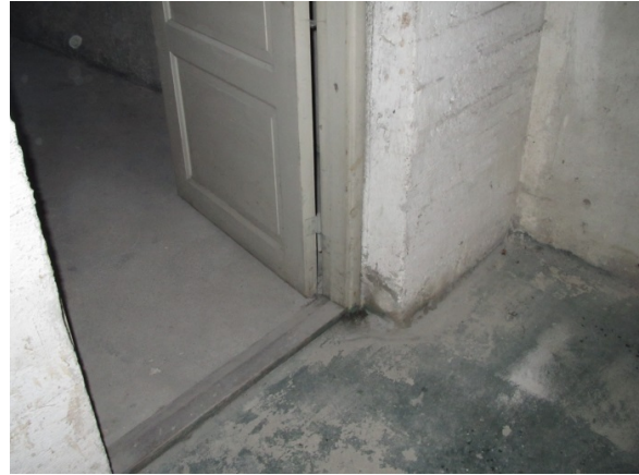
Foto 7 (SINTEF Byggforsk) Typisk detalj fra dør. Tredørene har ikke synlige tegn til å ha tatt skade fra vann i kjelleren.
