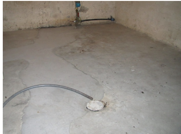
Foto 9 (SINTEF Byggforsk) Fra rom brukt som vaskerom i kjeller. Det er ingen synlige tegn til skader etter tidligere og gjentatte oppfukninger. Det er montert nytt sluk med tilbakeslagsventil i kjellerarealene.
