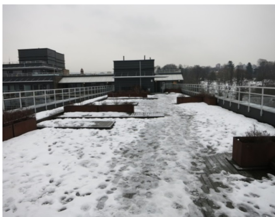
Foto 22 (SINTEF Byggforsk) Flate tak utformet som oppholdsarealer
