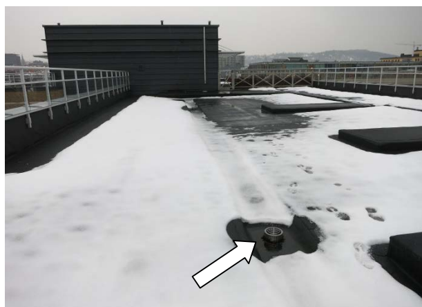
Foto 23 (SINTEF Byggforsk) Innvendig nedløp fra flatt tak
