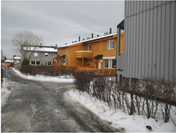
Foto 10 (SINTEF Byggforsk) Bygningene ligger på et hovedsakelig flatt terreng, men noen deler av området er svakt skrånende .
