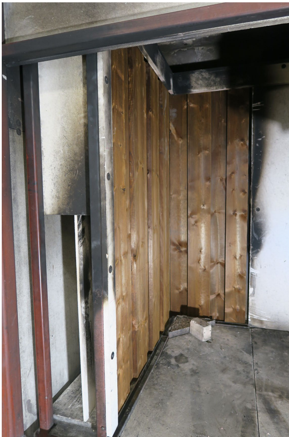
Foto nr 2 Före provning "E"
