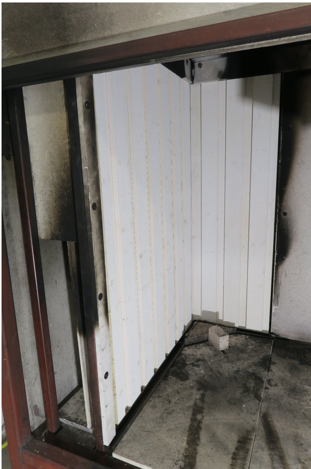
Foto nr 2 Före provning "B"
