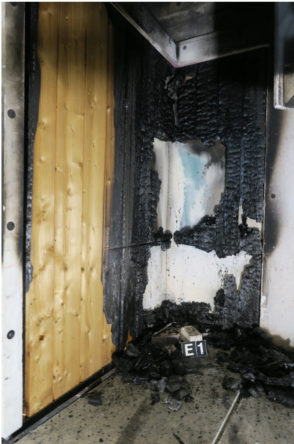
Foto nr 3 Efter provning "G"
