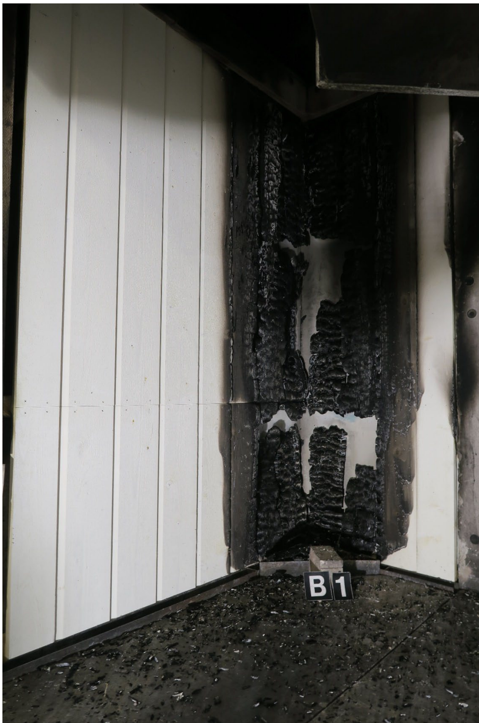
Foto nr 3 Efter provning "F"
