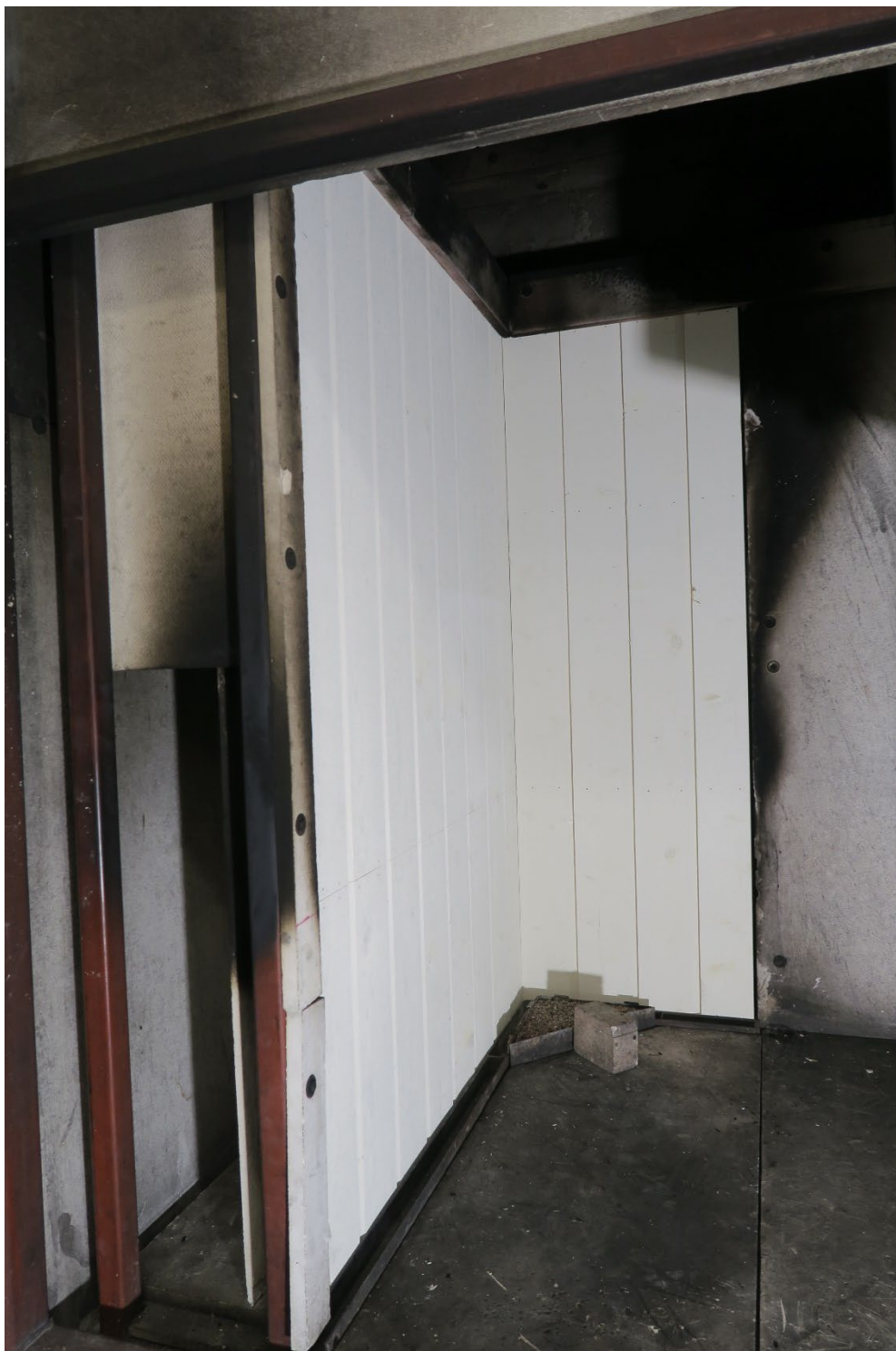
Foto nr 2 Före provning "F"
