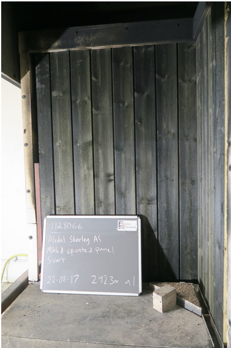
Foto nr 1 Före provning "N"
